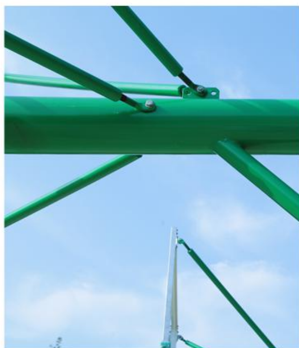
第三步：安装拉杆 长杆在上 短杆在下
